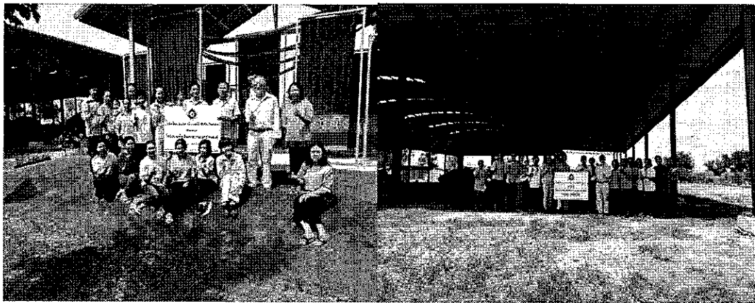
ต่อเติมอาคารอเนกประสงค์ (โดม) ระยะที่ 1 มูลค่า 300,000.- บาท ให้กับชาวบ้านหมู่ 15 สระบัวเก่า ตามโครงการ “ความร่วมมือเพื่อการพัฒนาชุมชน สังคม และสิ่งแวดล้อมอย่างยั่งยืน”
