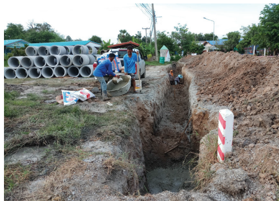
ฝังท่อระบายน้ำพร้อมบ่อพักที่บ้านสระบัวเก่า หมู่ที่ 7 เป็นเงิน 135,000.- บาท เพื่อช่วยเหลือชุมชน ให้สามารถระบายน้ำออกสู่ภายนอกได้สะดวก ป้องกันน้ำท่วมขังในหมู่บ้านในฤดูฝน ตามโครงการ “ความร่วมมือเพื่อการพัฒนาชุมชน สังคม และสิ่งแวดล้อมอย่างยั่งยืน” ประจำปี 2562
